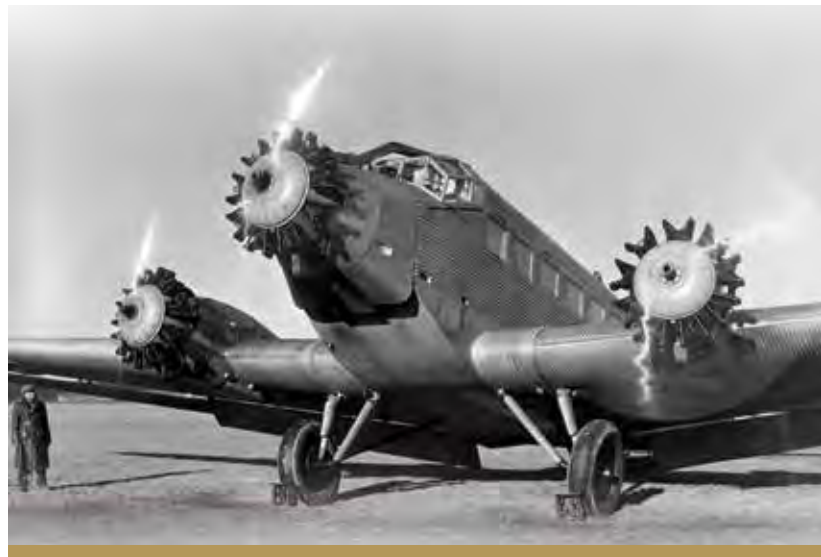
Junkers Ju 52 com 3 motores BMW. 1930
